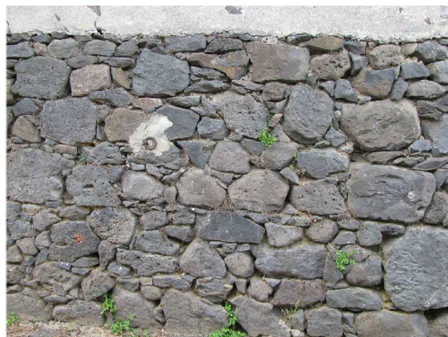
A.2 Tessitura muraria in conci di basalto appena sbozzati legati tra loro in terra e paglia.
