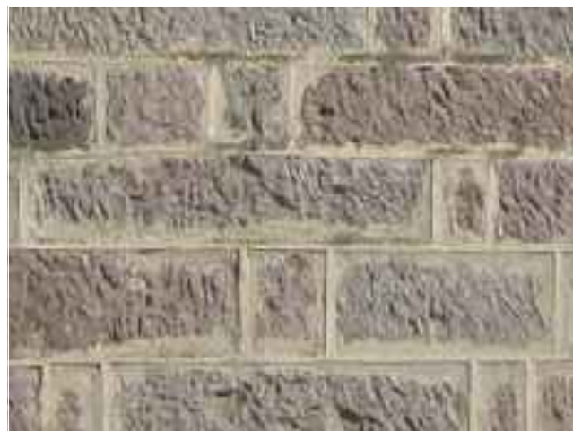
A.8 Tessitura muraria in conci squadrate di basalto disposti secondo corsi sub-orizzontali
