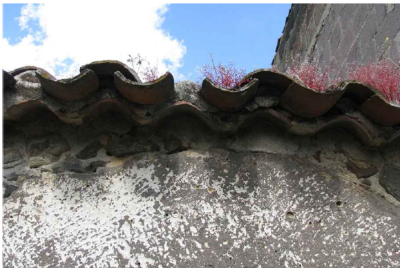
A.2 Aggetto su cornice realizzata con una fila di tegole convesse e smaltimento diretto delle acque
