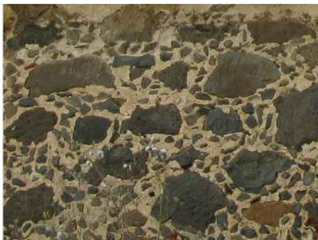
A.7 Tessitura muraria in conci appena sbozzati di basalto disposti secondo corsi sub-orizzontali allettati con malta di calce e con fughe decorate con l'innesto di piccoli ciottoli
