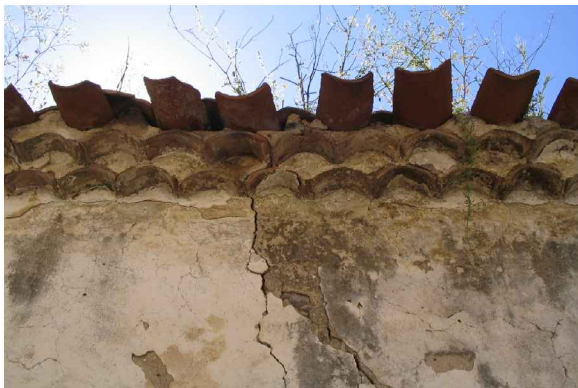
A.3 Aggetto su cornice realizzata con due file di tegole convesse e smaltimento diretto delle acque
