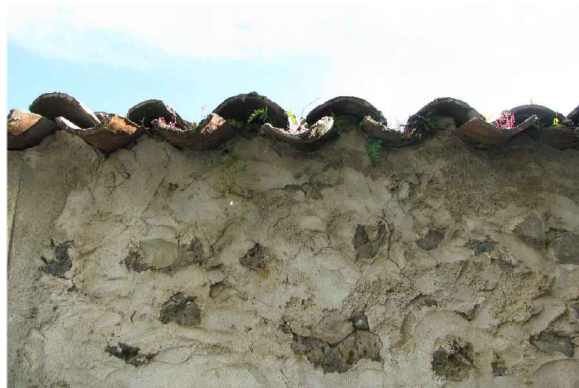
A.1 Aggetto semplice dei coppi canale con smaltimento diretto delle acque
