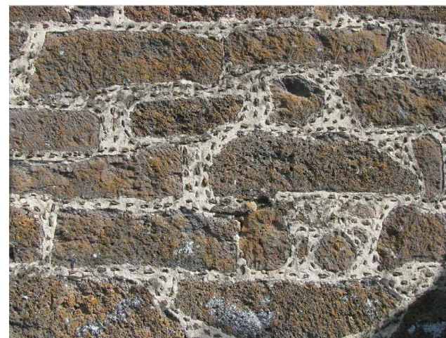
A.3 Tessitura muraria in conci appena sbozzati di basalto disposti secondo corsi sub-orizzontali con rinzeppatura in calce e in materiale lapideo di piccole dimensioni
