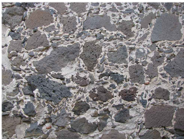
A.4 Tessitura muraria in conci appena sbozzati di basalto disposti secondo corsi sub-orizzontali e legati in calce e terra.
