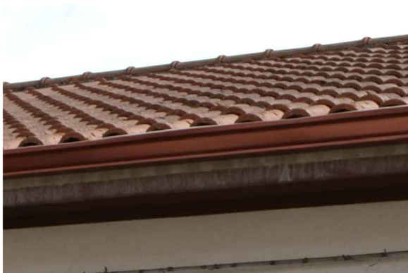
B.2 Cornice aggettante con modanature, muretto d'attico e smaltimento delle acque con canale di raccolta e discendente frontale
