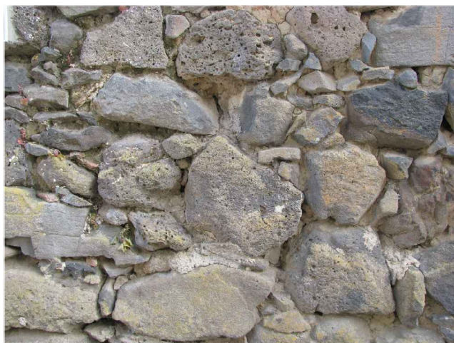
A.1 Tessitura muraria in trovanti di basalto e rinzeppatura con materiale lapideo di piccole dimensioni
