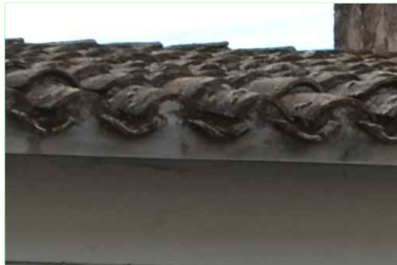
B.1 Cornice aggettante con modanature, priva di muretto d'attico e smaltimento delle acque con canale di raccolta e discendente frontale
