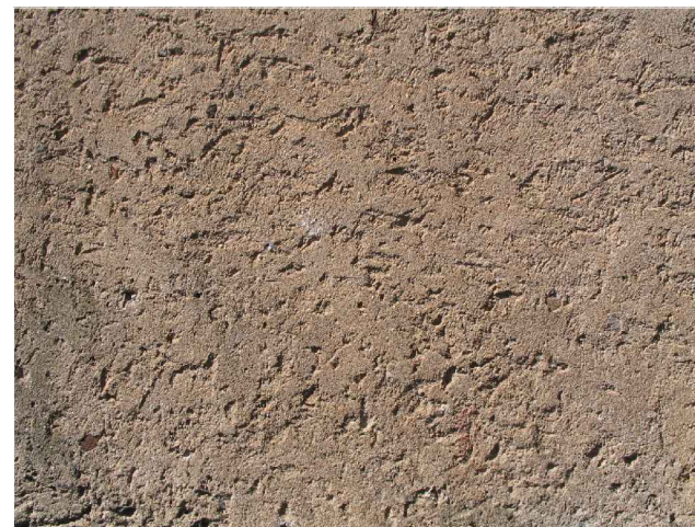
A.9 Muratura con finitura superficiale in intonaco di malta di calce senza o con tinteggiatura colorata
