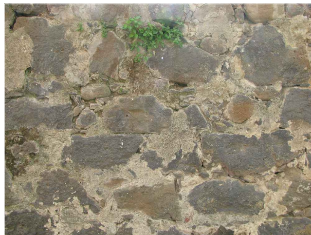
A.5 Tessitura muraria in conci squadrate di basalto quasi totalmente coperti con calce
