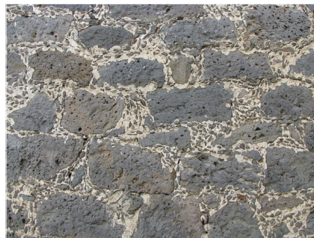
A.6 Tessitura muraria in conci squadrate di basalto disposti secondo corsi sub-orizzontali allettati con malta di calce e con fughe decorate con l'innesto di piccoli ciottoli.
